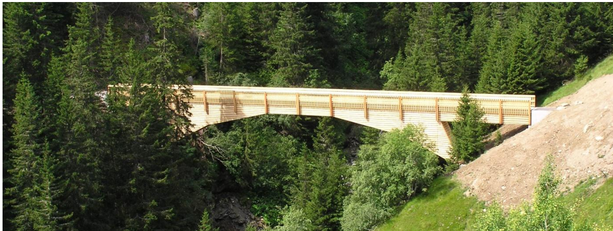
Bild 5: Holzbrücke auf dem „Senda Val Lumnezia“
